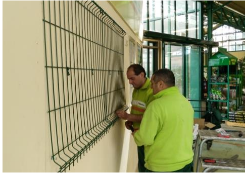
Montaje de los módulos
