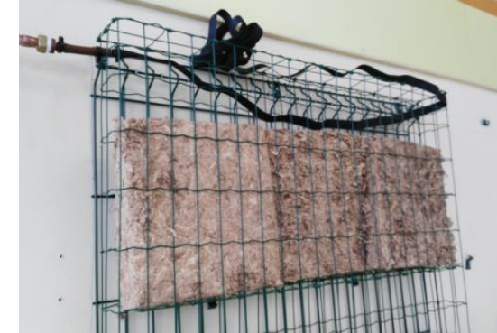
Colocación de paneles y riego
